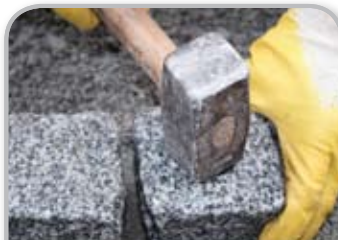
Verlegen der Steine
