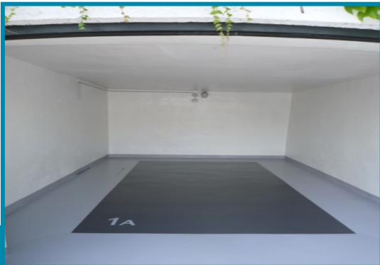
Garage, inklusive Wand- und Deckenbeschichtung
