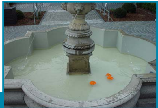
Brunnen – dekorative Abdichtung
